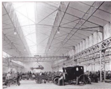
L'atelier de montage des carrosseries des usines Renault en 1907.
